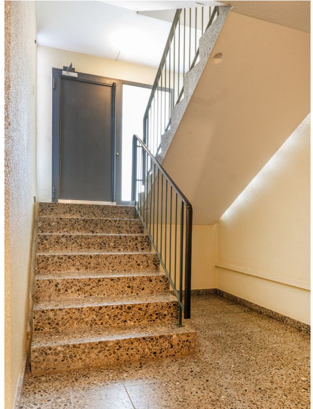
Treppenhaus UG -Eingangsbereich
