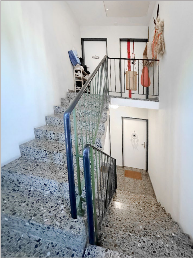
Treppenhaus 1. OG – 2. OG
